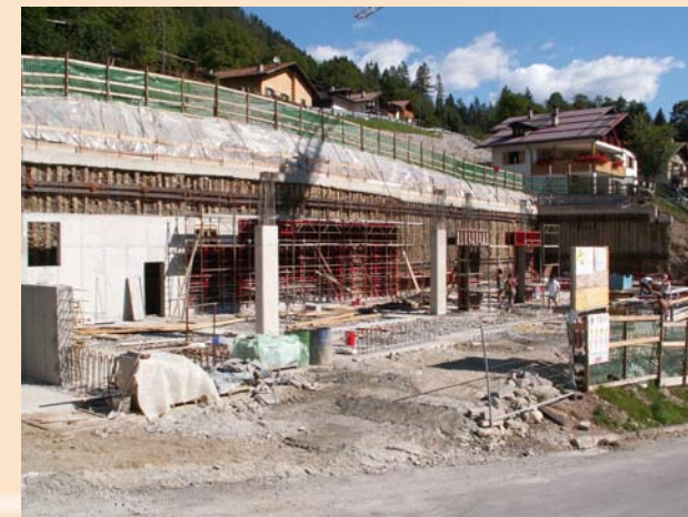
Impermeabilizzazione e protezione strutture interrato Edifici in Pinzolo e Caderzone (TR), assistenza tecnica studio BINDO
