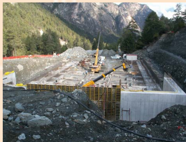
Visione generale del cantiere
