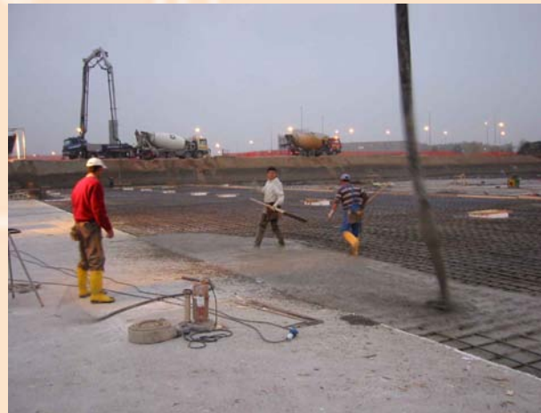
Esecuzione dei getti in calcestruzzo
