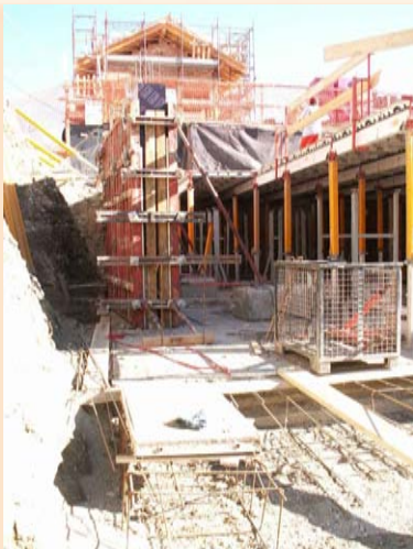
PP3 “Giunto di ripresa di getto platea-muri di contenimento”
