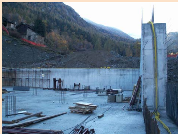
Visione dei giunti di costruzione in pvc
