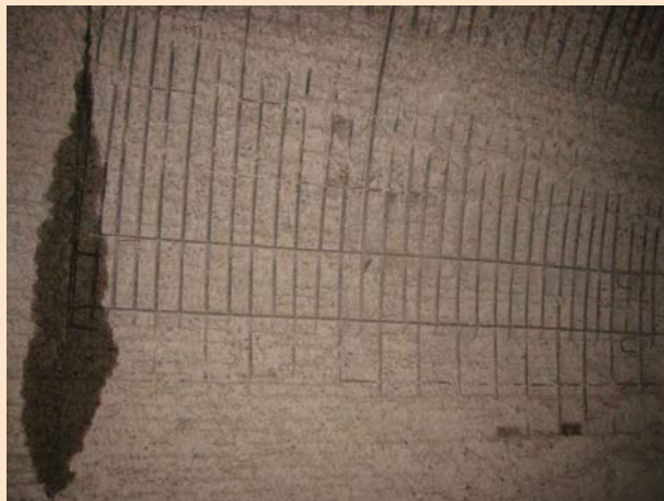
Visione della calotta dopo le operazioni di scarifica
