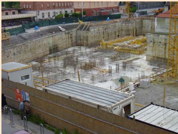
Visione generale del cantiere
