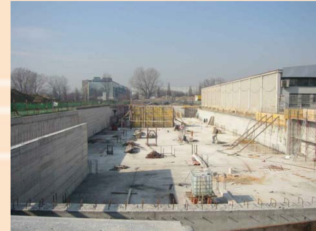
Visione generale del cantiere
