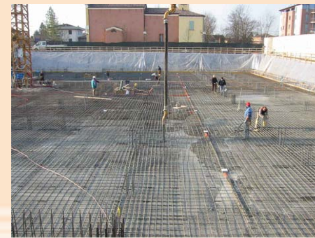
Esecuzione dei getti in calcestruzzo
