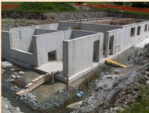
Impermeabilizzazione e protezione strutture interrato Edifici in Pinzolo e Caderzone (TR), assistenza tecnica studio BINDO
