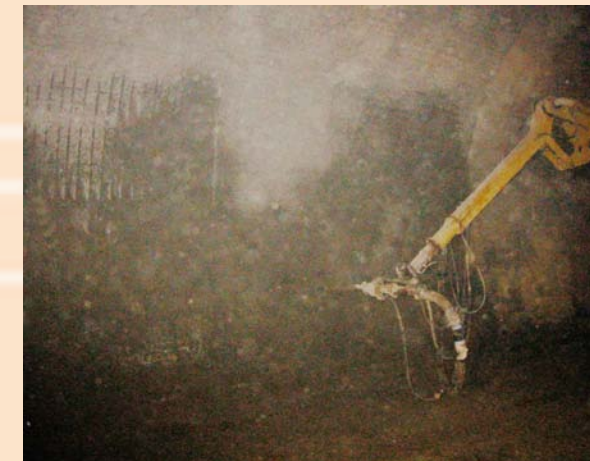
Applicazione dello spritz-beton con il Penetron Admix
