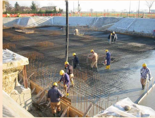
Esecuzione dei getti in calcestruzzo
