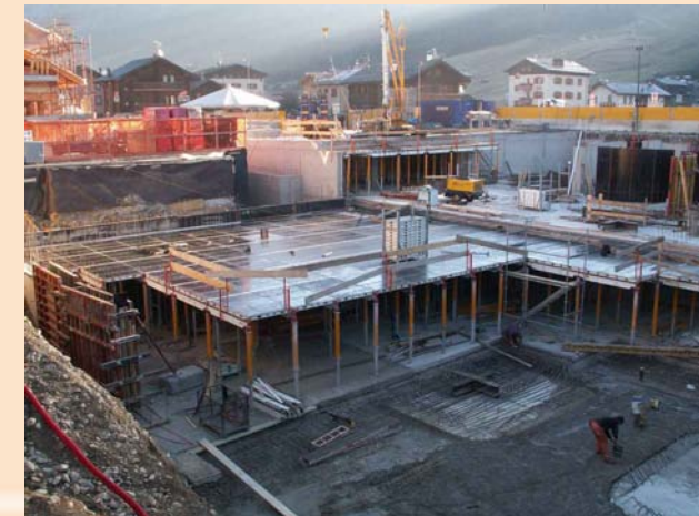
Visione generale del cantiere
