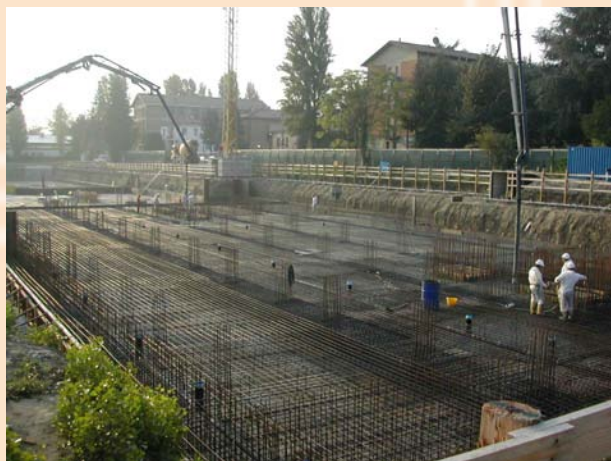
Esecuzione dei getti in calcestruzzo
