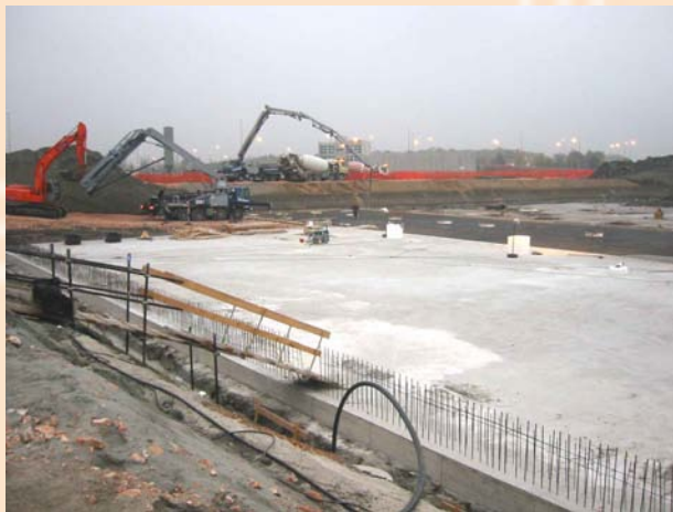
Esecuzione dei getti in calcestruzzo
