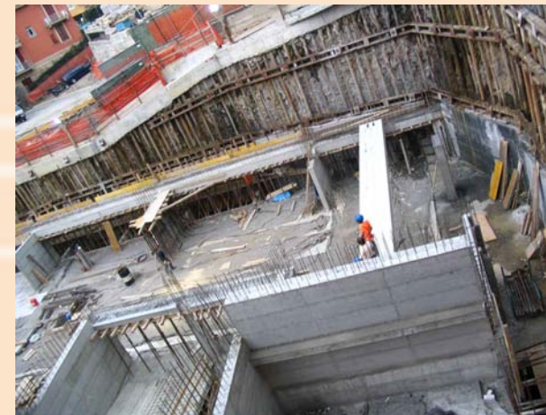
Visione generale del cantiere
