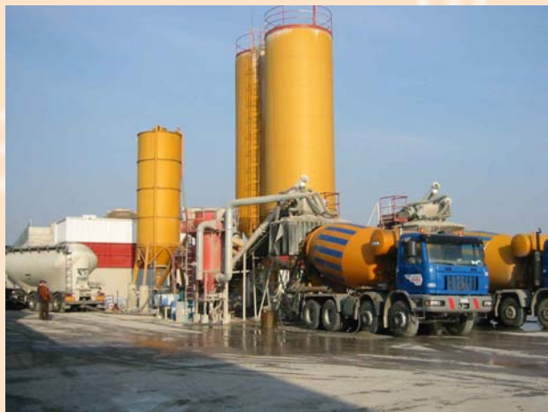
Miscelazione in centrale di betonaggio
