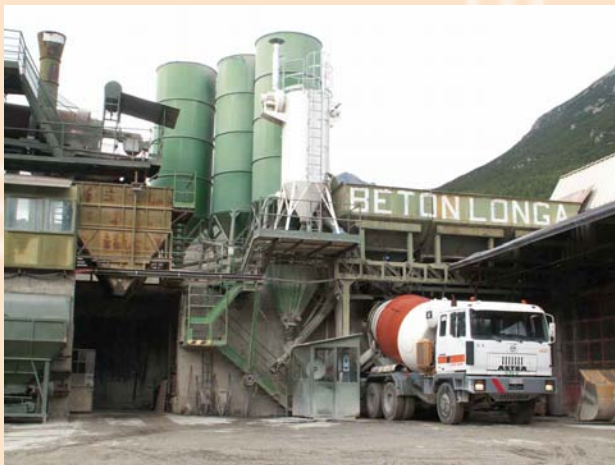
Centrale di betonaggio Livigno Scavi srl
