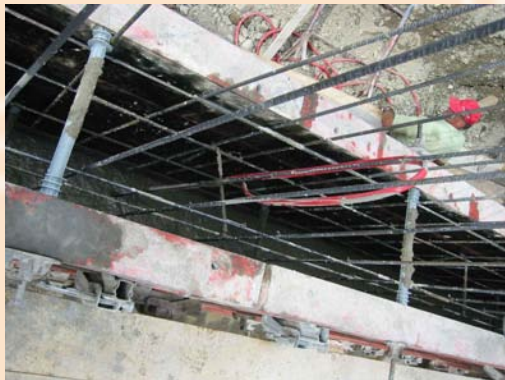
PP1 “Giunto di frazionamento dei muri di contenimento”
