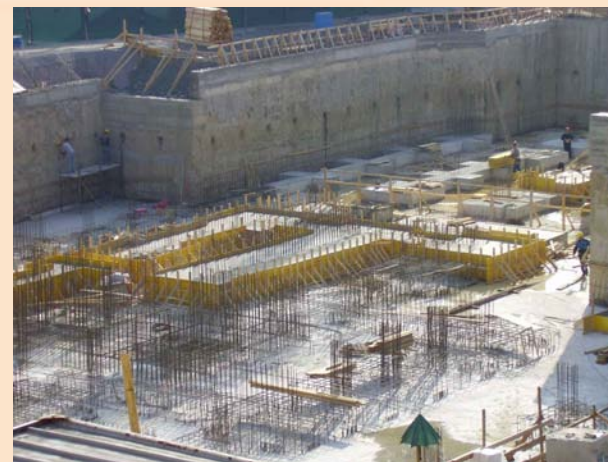
Visione generale del cantiere
