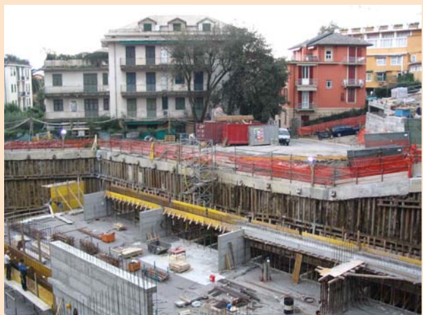
Visione generale del cantiere
