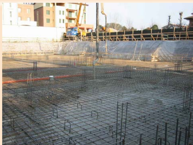
Esecuzione dei getti in calcestruzzo
