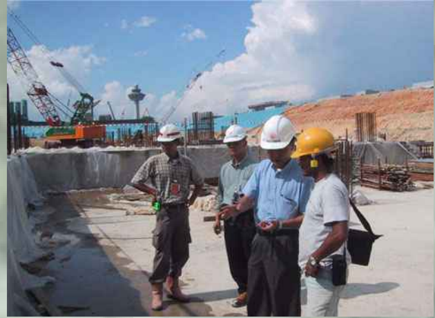
Visione generale del cantiere
