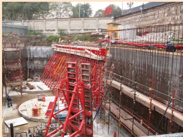
Impermeabilizzazione e protezione strutture interrato e vasche di contenimento “Centrale Teleriscaldamento AEM”, Torino
