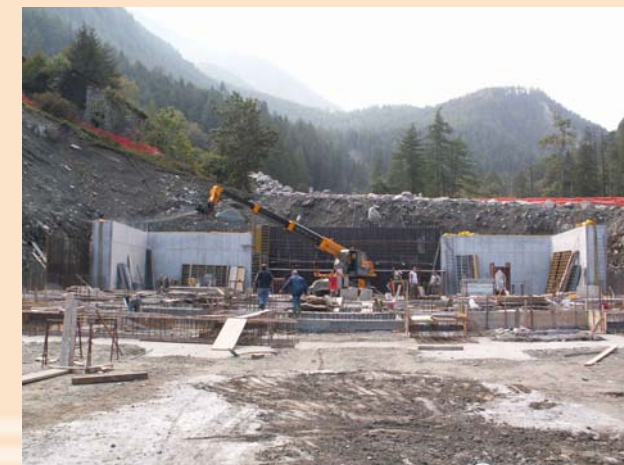
Visione generale del cantiere
