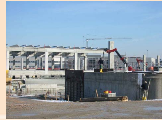
Visione generale del cantiere
