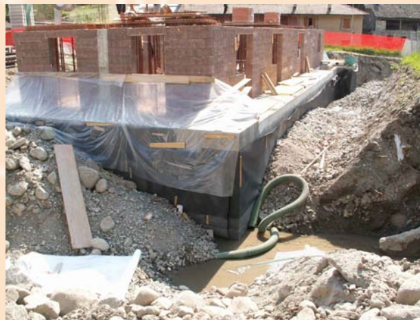
Impermeabilizzazione e protezione strutture interrato Edifici in Pinzolo e Caderzone (TR), assistenza tecnica studio BINDO
