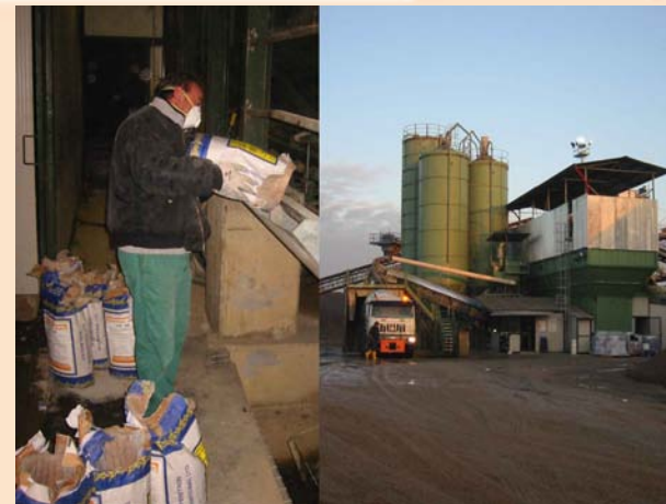
Miscelazione a secco in Centrale del Penetron Admix
