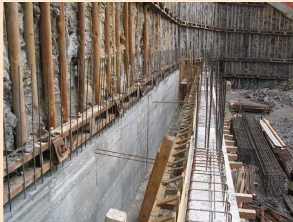
Visione dei muri di contenimento contro diaframmi
