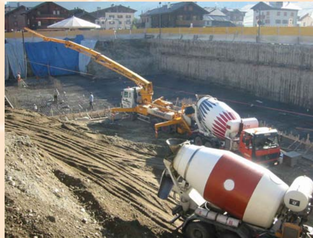
Esecuzione dei getti in calcestruzzo
