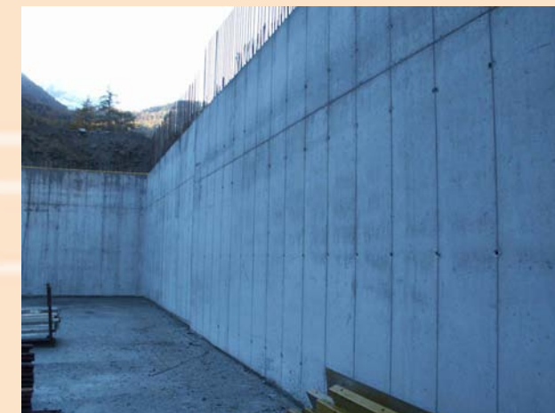
Visione dei muri di contenimento
