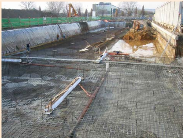
Esecuzione dei getti in calcestruzzo
