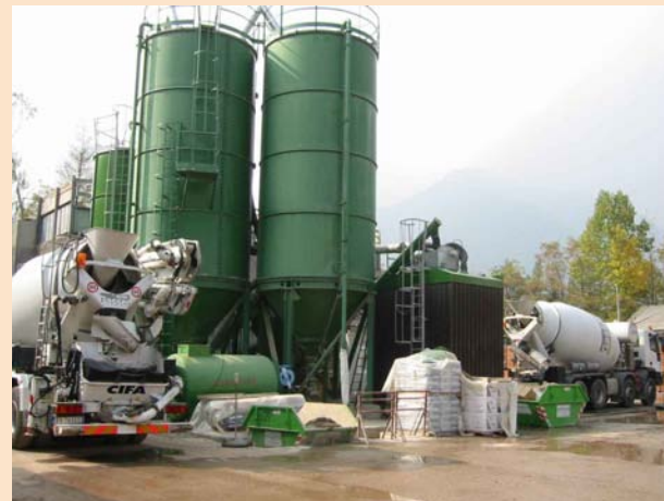
Confezionamento dello “spritzz umido” con il Penetron Admix
