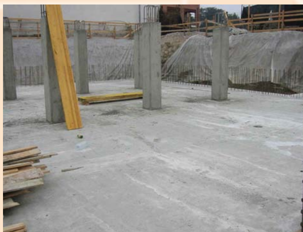
Visione generale del cantiere
