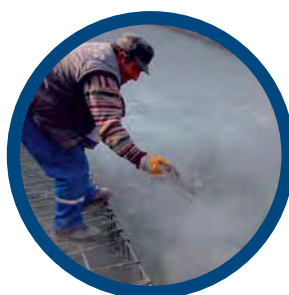
Spolvero del Penetron su superfici orizzontali fresche di getto
