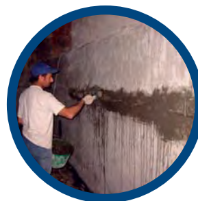
Esecuzione dello scasso e Penetron boiaccia di fondo
