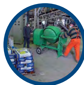
Miscelazione a secco: Penetron e quarzo
