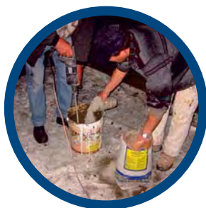
Miscelazione con frullino meccanico
