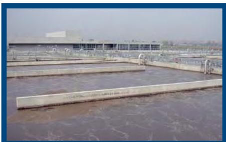
Depuratore Sud di Milano, Rozzano, MI - (2003)
